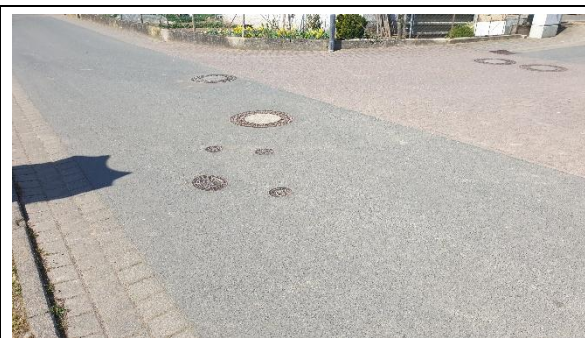
Foto 1: Straße Am Hollergraben
