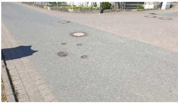
Foto 1: Straße Am Hollergraben
