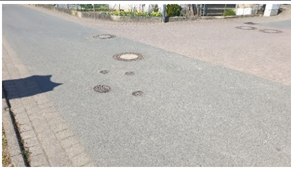
Foto 1: Straße Am Hollergraben
