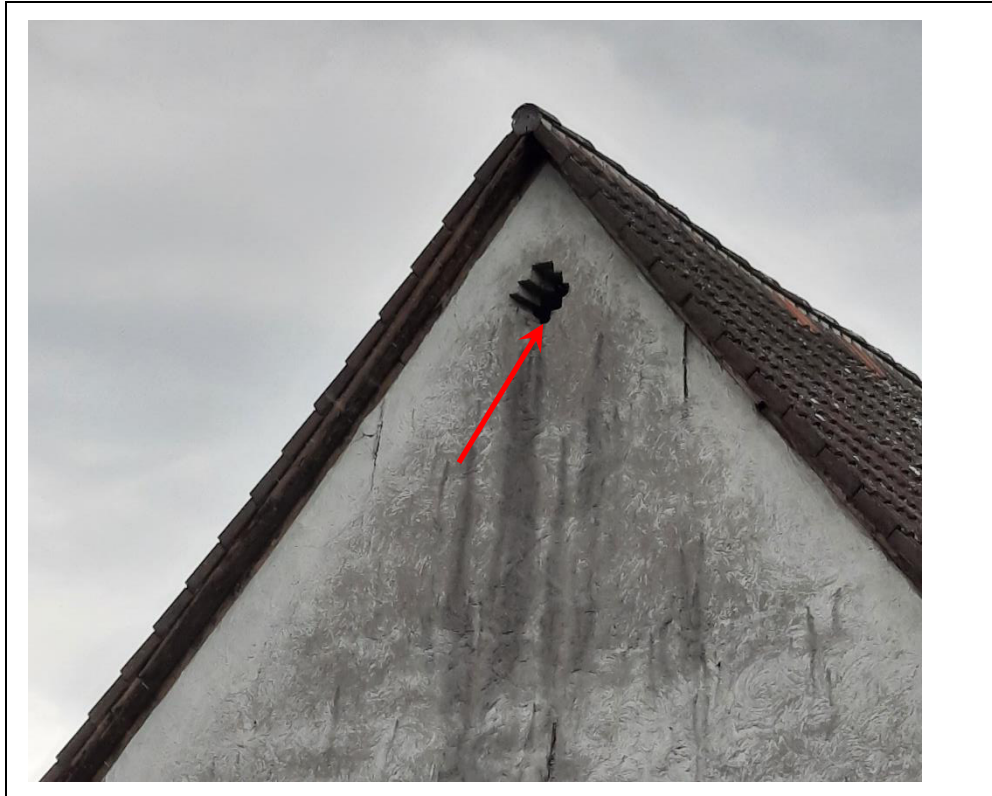
Abbildung 7: Lüftungsöffnung in einer Scheune
