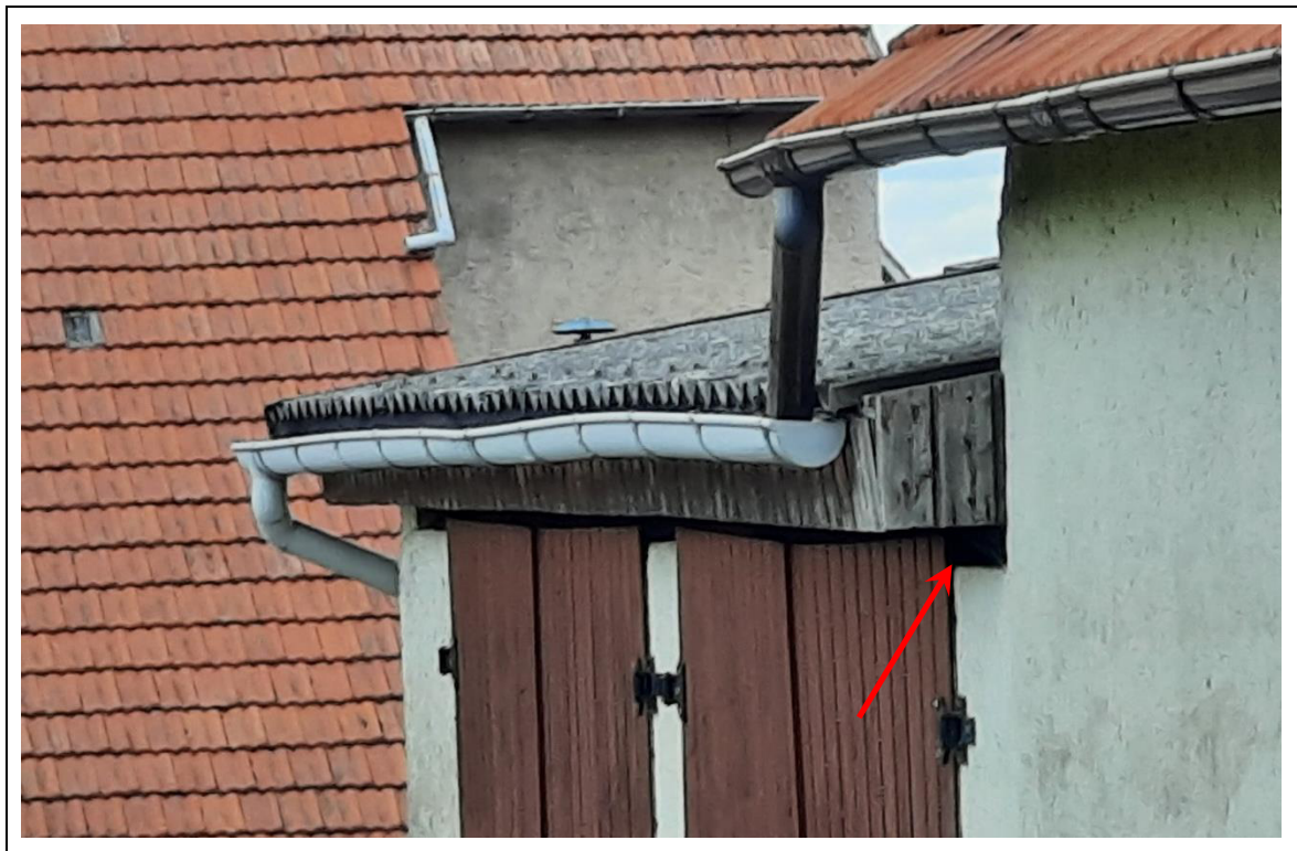
Abbildung 6: Beispiel für einzelne Öffnungen in der Scheunenwand
