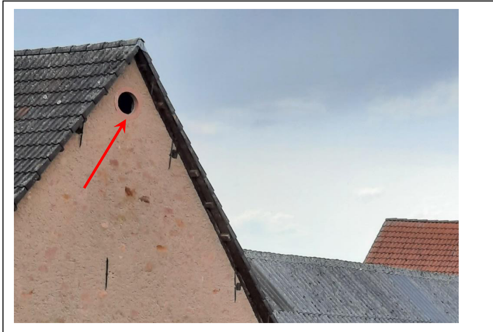
Abbildung 5: Lüftungsöffnung in einer Scheune
