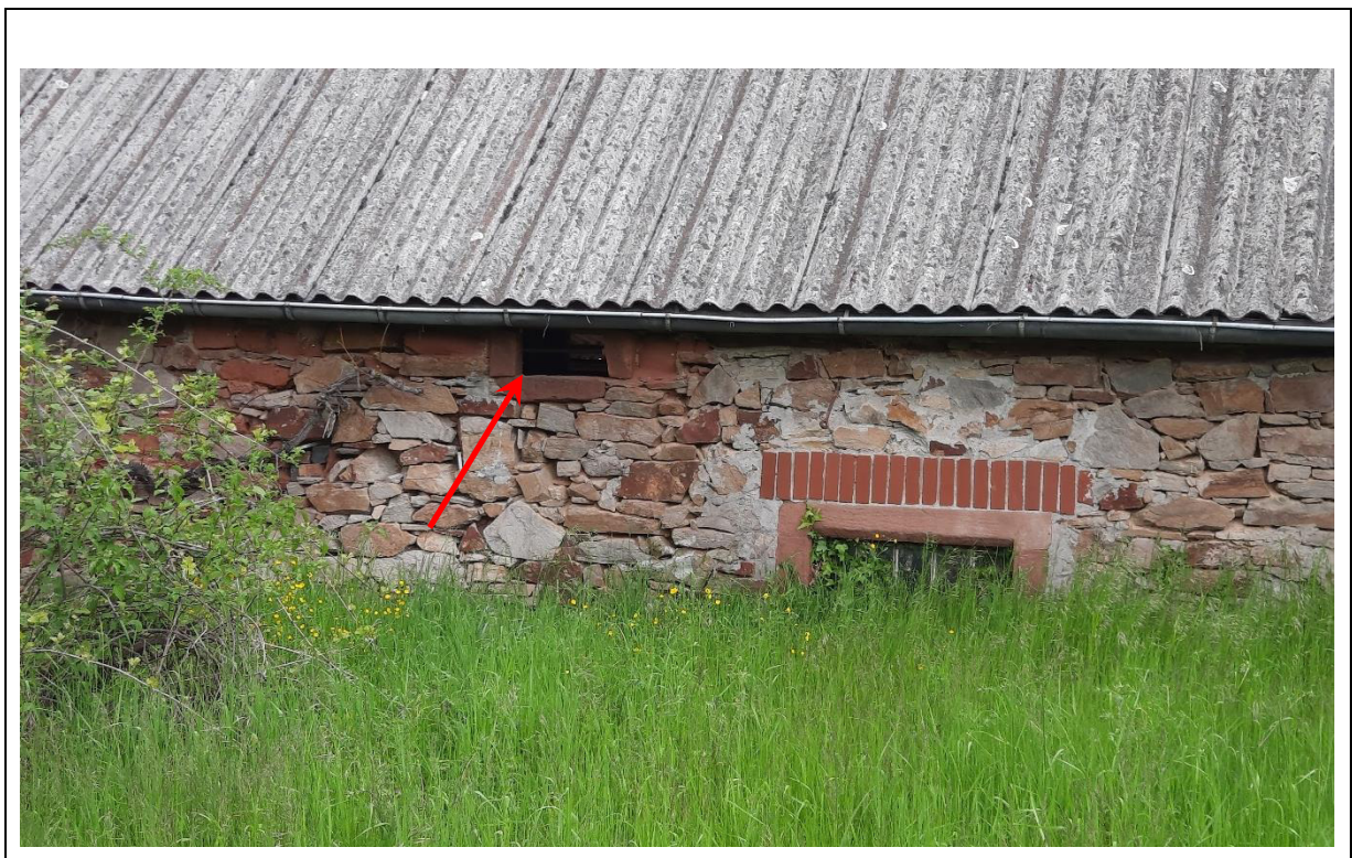
Abbildung 8: Öffnung in Mauerwerk, Mauerspalten
