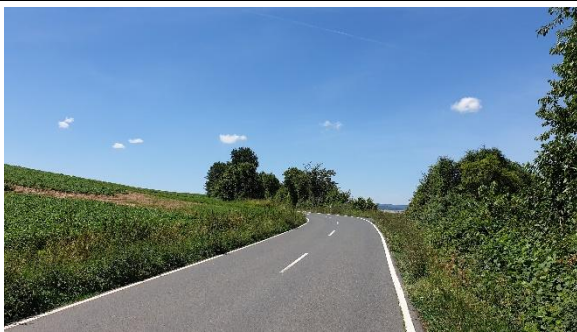
Foto 10: Raiffeisenstraße / K 116 mit beidseitiger Böschung / Graben
