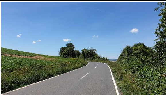
Foto 12: Raiffeisenstraße / K 116 mit beidseitiger Böschung / Graben
