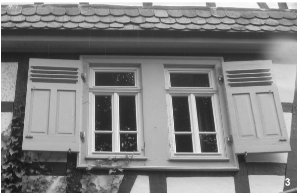
1) Neue Holzfenster in historischer Bauweise als Kastenfenster
